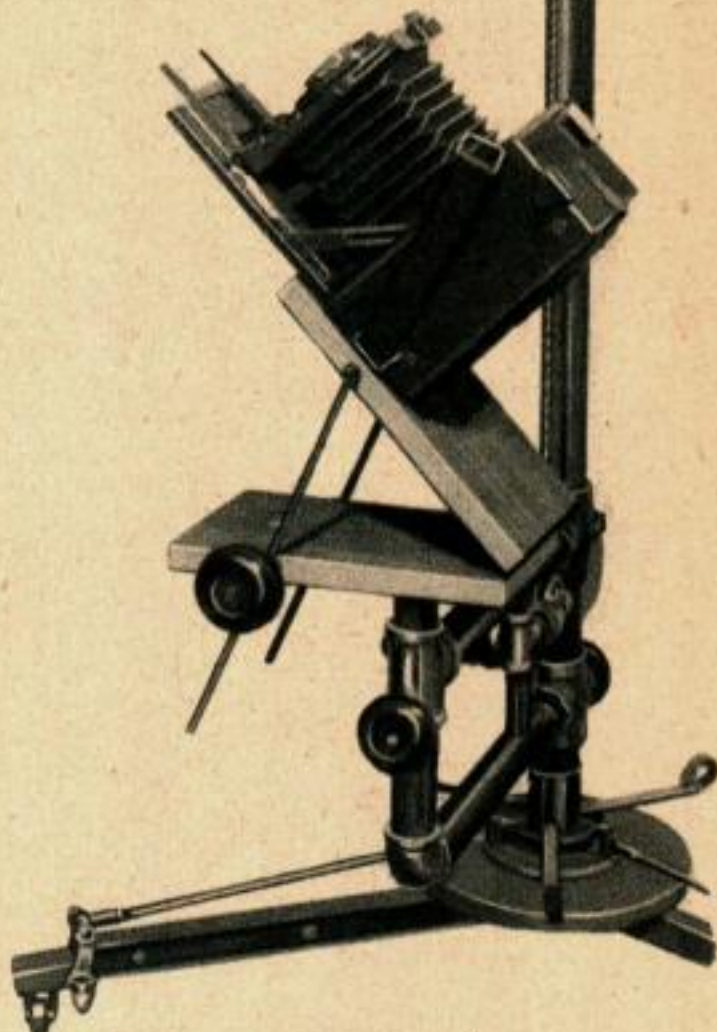
On peut, à volonté, orienter l'appareil vers le haut ou le bas au moyen de ce pied universel d'atelier.
