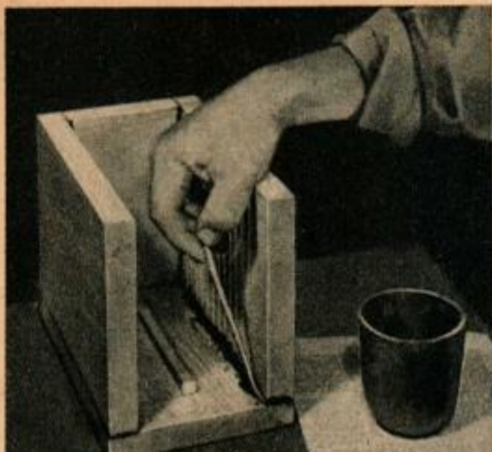
Mettre un fort congé en colle hydrofuge afin de donner plus d'étanchéité à l'assemblage.
