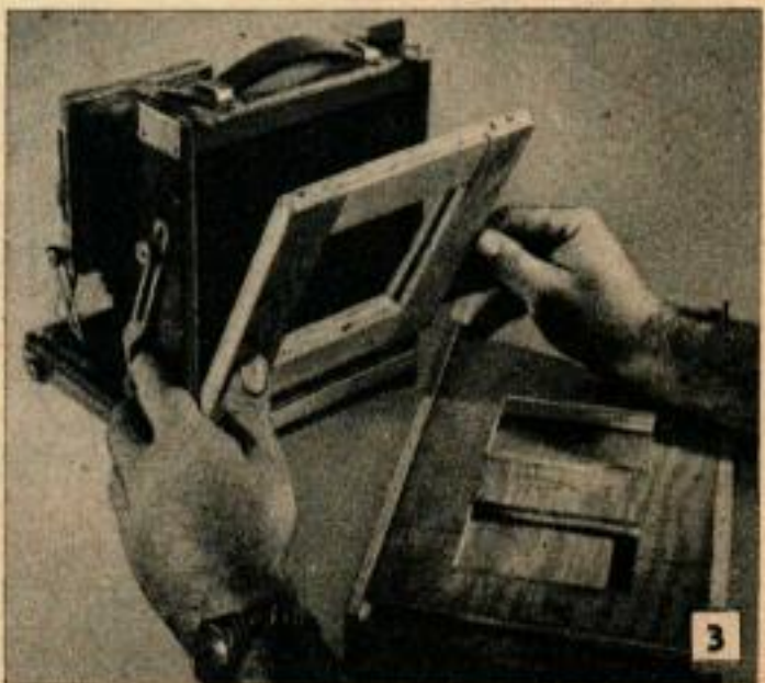
Ci-dessus, adaptateur en position pour prendre une vue horizontale. Le panneau porte-film ou porte-plaque a été déplacé dans la coulisse pour mettre le film devant la fenêtre de l'appareil. Ci-dessous, vérification de la mise en place correcte de l'adaptateur sur l'appareil photographique.
