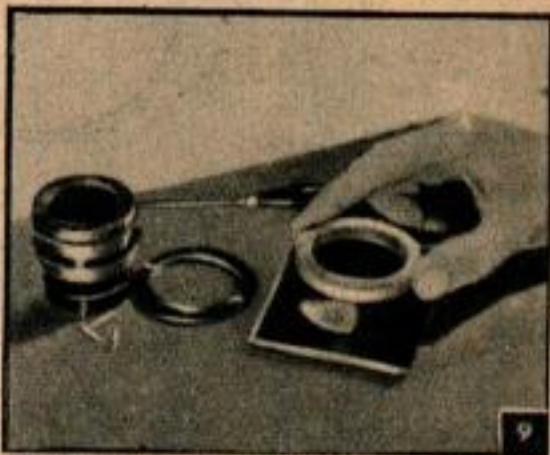
Une rondelle d'objectif entre l'objectif et la planchette porte-objectif permettra plus de latitude dans les photos de gros plan.
