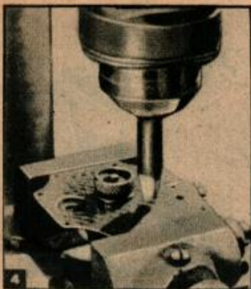
On peut décorer les parties métalliques apparentes par un polissage fait sur une perceuse.
