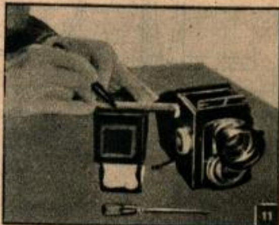
Des lignes tracées sur l'écran Reflex indiquent les corrections qui sont faites pour le parallaxe.
