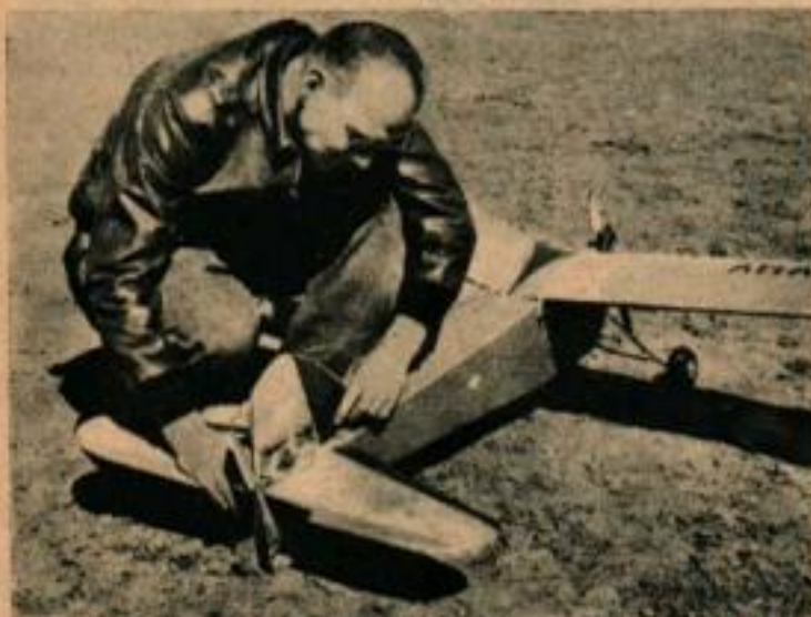
La télécommande de cet avion ne pèse que 31 g et commande l'allumage et les 2 vitesses du moteur. Elle dirige les empennages horizontaux et verticaux. Son nom est «Rudevator». On le voit ici entre les mains de Richard Schumaker de San Diego.
