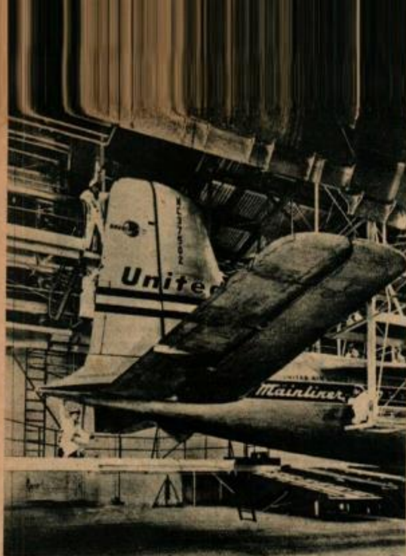
Ici une seule des deux parties du cadre est abaissée, permettant à trois ouvriers de travailler sur la queue du DC-6 à des hauteurs différentes. À droite, 4 vérins hydrauliques soulèvent le train d'atterrissage au-dessus du sol.
