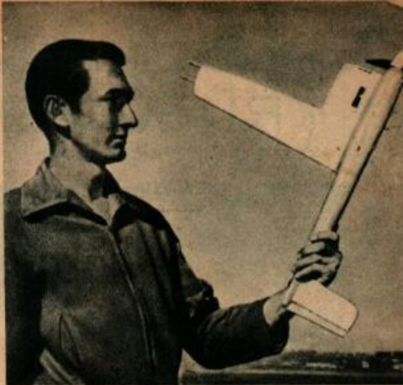
Avion à une seule aile et à un demi-empennage horizontal, à moteur latéral, construit par Glenn F. Crist de Modesta (Etat de Californie). Il a dépassé officiellement la vitesse de 240 km/h.
