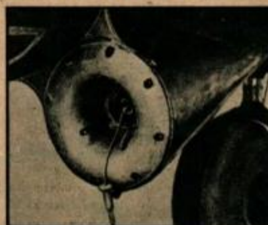
Ci-dessous, connexion sur l'avion alimenté, au travers de laquelle passe le câble traîné par l'avion alimenteur.
