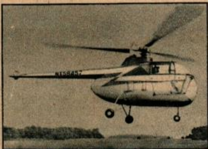
Le biplace de Firestone peut s'élever de 370 mètres en une minute et parcourir plus de 350 kilomètres avec 125 litres d'essence. Cet appareil a un moteur refroidi par air de 175 chevaux.
