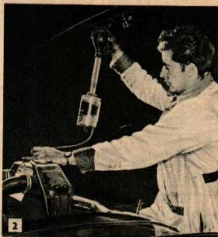
Avec un densimètre spécialement adapté à cet usage, on vérifie que le point de congélation du liquide du radiateur est suffisamment bas.
