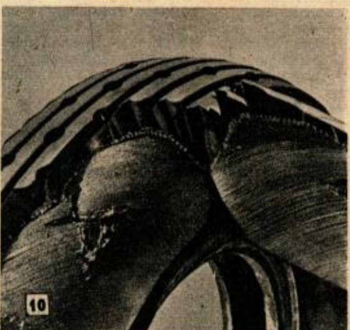
La fissure de gauche (fig. 9) conduit toujours à cette explosion brutale qui a déchiré et séparé une partie de la bande.
