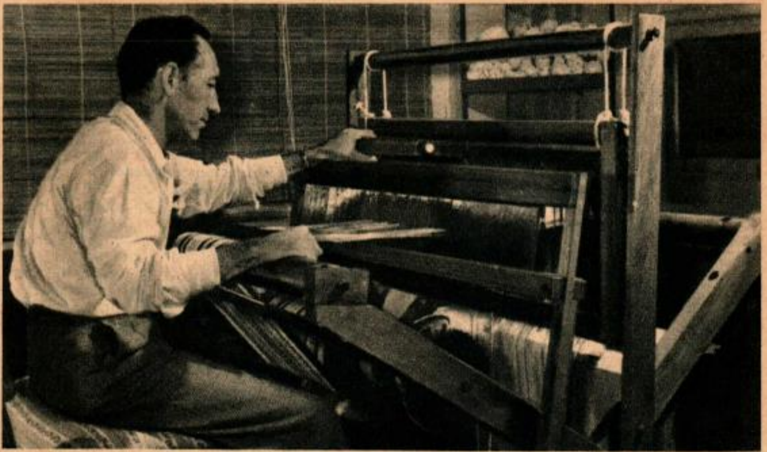
Les cordonnets ayant été disposés convenablement sur le métier, chaque feuille est insérée individuellement, et la navette est actionnée à la main.
