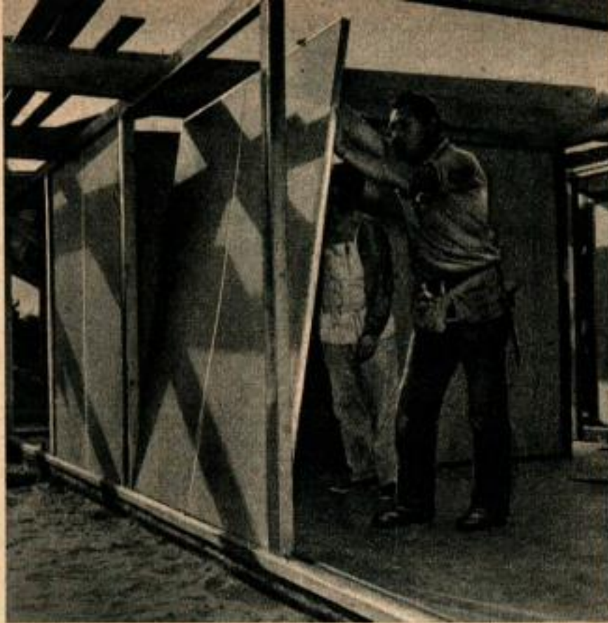
Des charpentiers dressent l'un des panneaux formant mur extérieur. L'espace intérieur gagné grâce à ces murs peu épais, représente 14 m 2 (150 sq. ft.).
