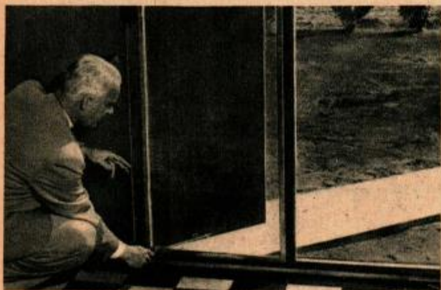
Cox fait fonctionner un système d'ouverture des fenêtres fixé sur un panneau d'une maison de campagne. Le panneau vitré, à droite, fait partie de la construction et ne peut s'ouvrir.
