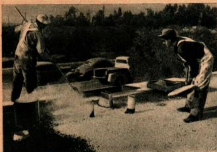
Dans la maison en panneaux, les panneaux du toit sont recouverts de papier goudronné, d'une feuille isolante d'aluminium et d'une ultime couche de gravier très fin.
