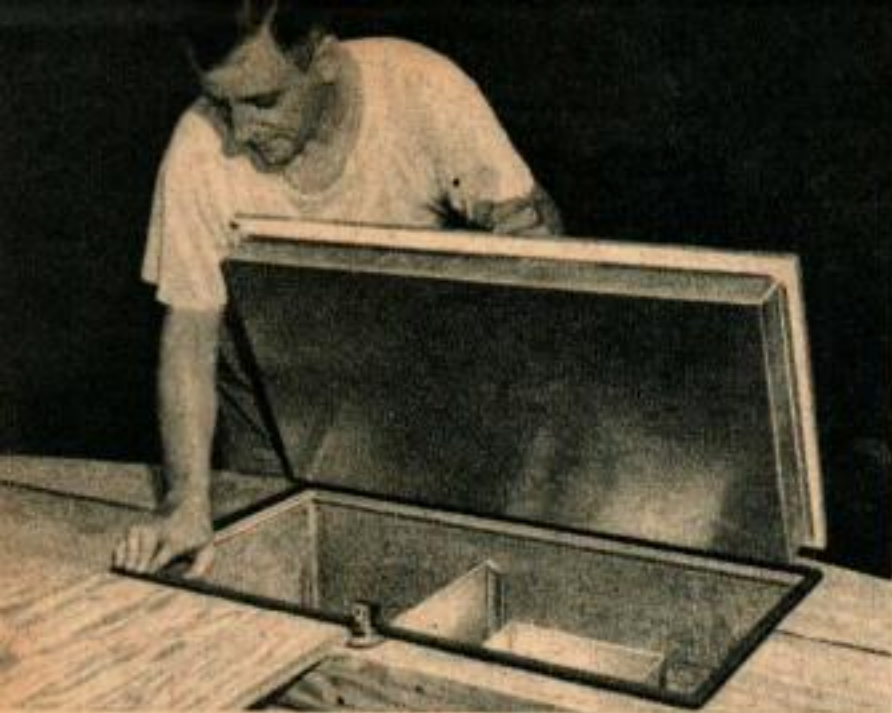
Les bourrelets d'étanchéité des fenêtres donnent une très bonne garniture pour le couvercle de la glacière.
