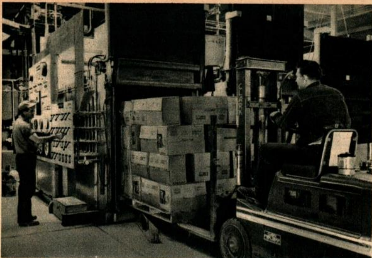
Les boîtes de laitues sont placées dans une chambre à refroidissement par le vide qui abaisse la température à 1° C environ (34° F.). Il n'y a pas besoin de glace.
