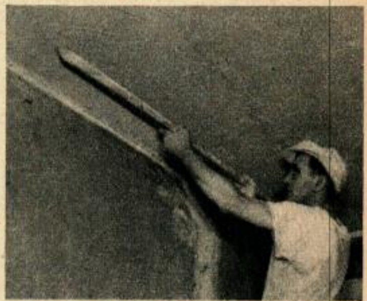
Le plâtre est étalé avec une règle puis une taloche que l'on utilise de telle sorte qu'elle laisse une surface rugueuse sur laquelle on met un enduit final de 1,5 à 3 mm (1/16 à 1/8 in.).
