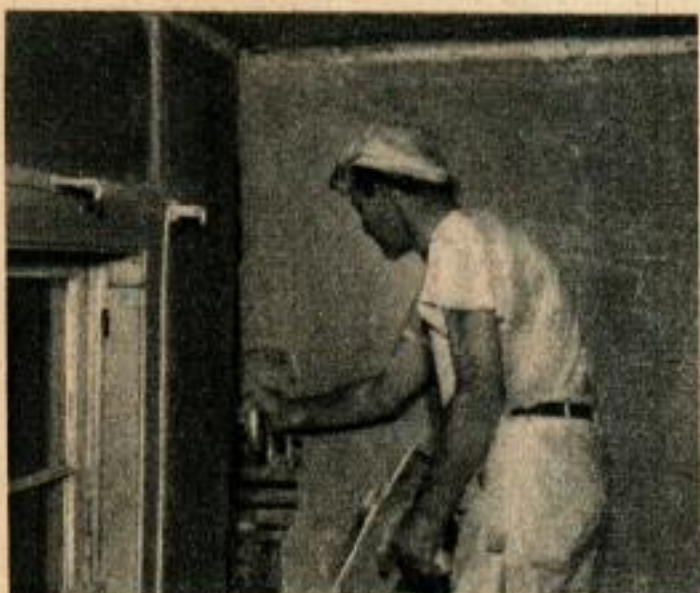
Une fissure dans un mur se répare en opérant comme pour enduire un plafond. On nivelie à la truelle ou à la taloche. On laisse les surfaces rugueuses pour faciliter l'accrochage de l'enduit final de plâtre.
