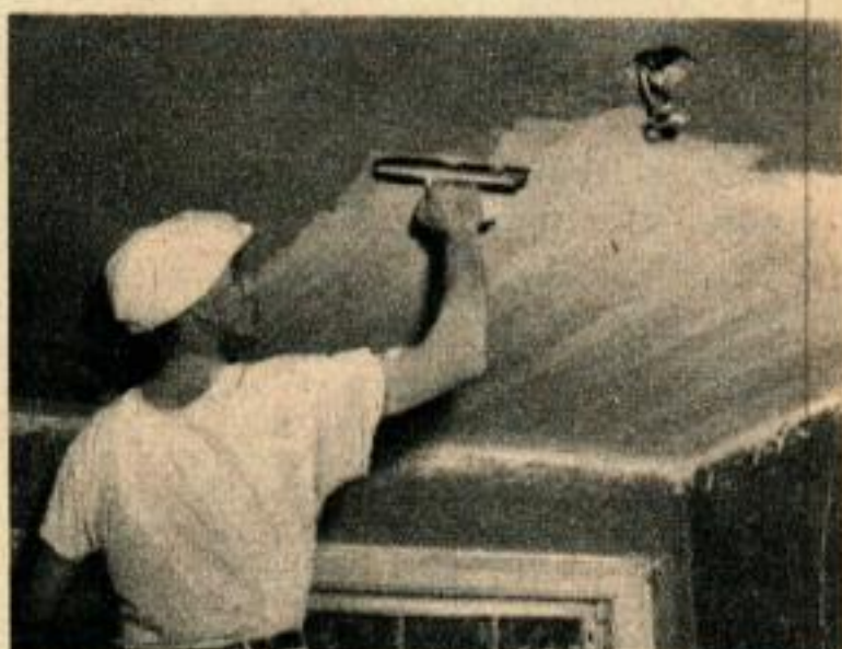
L'enduit définitif en plâtre spécial se pose 24 heures après le séchage de la couche d'enduit. Ci-dessus, début de l'opération, on commence vers les murs et on finit au centre du plafond.
