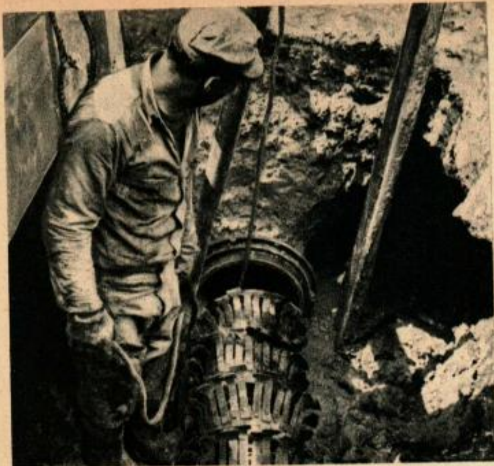
Les canalisations sont nettoyées au hérisson muni de lames d'acier recourbées, et qui est poussé par la pression de l'eau dans la conduite à nettoyer. Ci-dessous, jaillissement de l'eau qui pousse le hérisson lors de la sortie de ce dernier.
