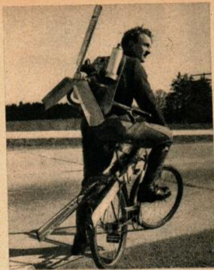
Bicyclette à hélice qui constituerait un avion s'il y avait des ailes. Le moteur est placé sur le dos du conducteur et actionne une hélice qui fait avancer le véhicule et son conducteur. →
