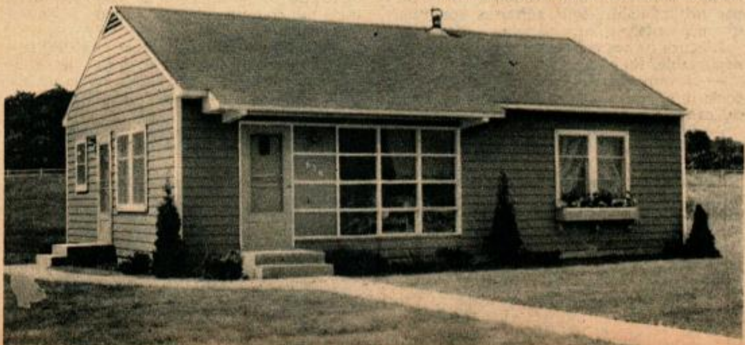
Swift Homes, Inc., Clairton, Pennsylvanie. Autre exemple de maison à quatre chambres à coucher entièrement construite en usine et assemblée sur place. Le client fournit le terrain et fait creuser les fondations. Ci-dessous, maison à trois chambres à coucher dont les murs sont livrés complètement terminés y compris les portes et fenêtres. Prix de 8 500 à 13 500 dollars (3 000 000 à 5 700 000 fr. F.), elle ne se vend qu'aux entrepreneurs qui la montent pour leurs clients.
