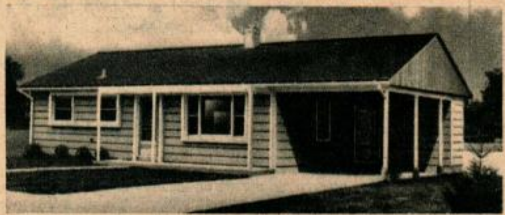
P. & H. Homes, Harnischfeger Corp., Port Washington, Wisconsin. Maison livrée en panneaux distincts : les murs sont assemblés à l'usine et montés lors de la livraison. Noter à droite, l'abri de la voiture avec vaste placard dans le fond. On traverse la cuisine pour gagner la salle à manger.
