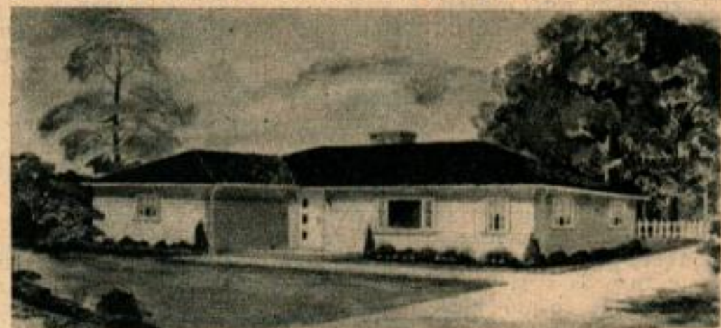
Swift Homes, Inc., Clairton, Pennsylvanie. Autre exemple de maison à quatre chambres à coucher entièrement construite en usine et assemblée sur place. Le client fournit le terrain et fait creuser les fondations. Ci-dessous, maison à trois chambres à coucher dont les murs sont livrés complètement terminés y compris les portes et fenêtres. Prix de 8 500 à 13 500 dollars (3 000 000 à 5 700 000 fr. F.), elle ne se vend qu'aux entrepreneurs qui la montent pour leurs clients.
