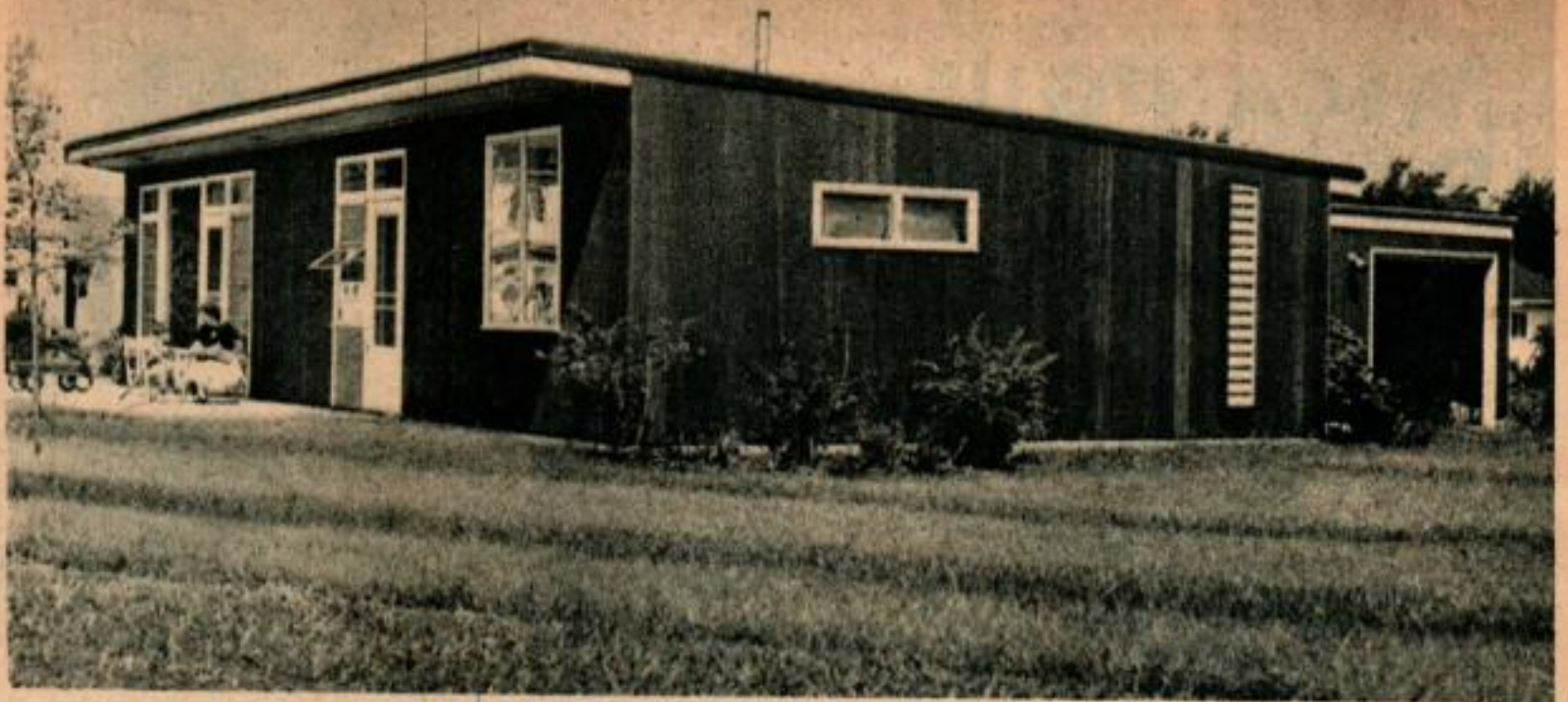
L'architecte Jones, auteur de cet article, a construit ici une maison qui matérialise un certain nombre des idées qui lui sont chères. La présente photo est prise dans la direction de la flèche n° 1, sur le plan de la page ci-contre. Noter, sur les deux murs principaux, le débordement du toit qui aide à lutter contre le soleil.
