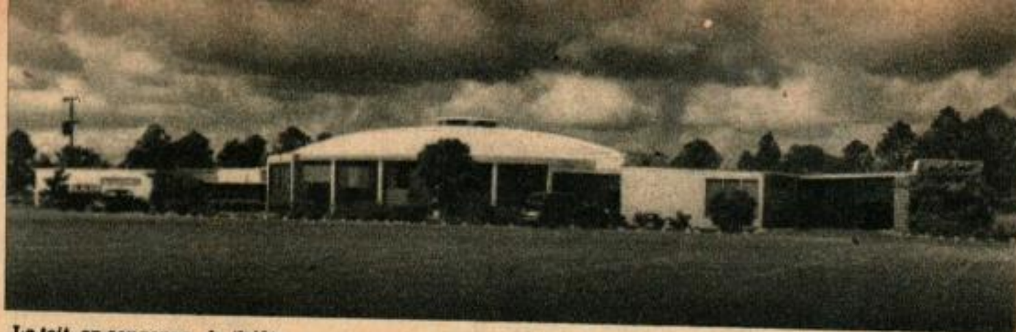
Le toit, en soucoupe, du théâtre repose sur des poteaux d'acier disposés circulairement. Les ateliers et bureaux sont logés dans les ailes.
