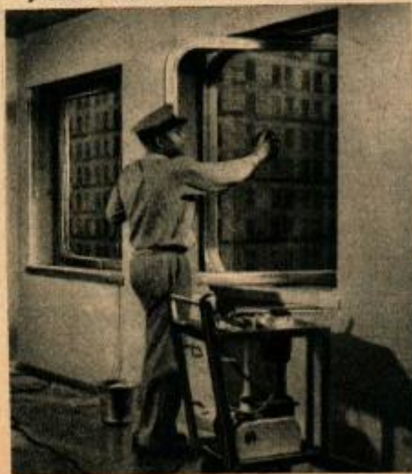
Cet outil en Y dégonfle et regonfle un joint pneumatique en caoutchouc, avant et après le nettoyage des vitres. Ci-dessous: les vitres pivotent autour d'un axe vertical, pour que leur lavage soit particulièrement facile à faire. Le petit chariot porte un moteur et un compresseur alimentant l'outil ci-dessus.
