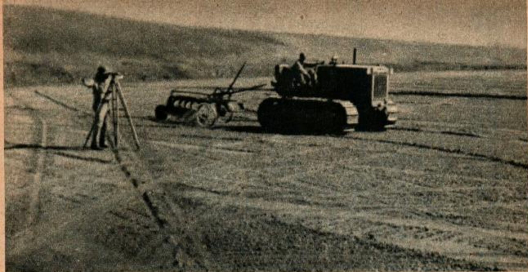
Un géomètre suivi d'un tracteur avec charrue procède au nivellement d'une immense rizière californienne.
