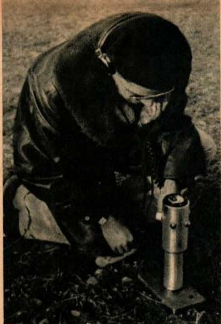
Pour établir l'influence exacte des radiations cosmiques, le prospecteur place son « revolver » sur un écran de plomb qui arrête les radiations du sol.
