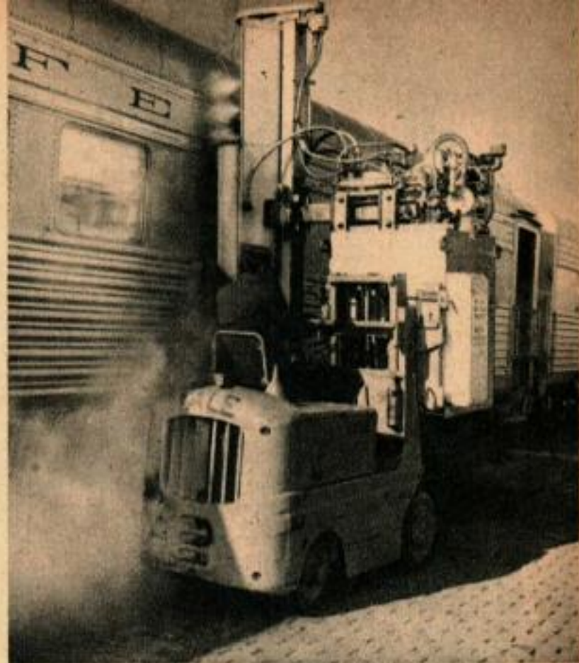
Un train de douze voitures consomme 7.500 litres d'eau potable. Chaque voiture a son propre réservoir.
