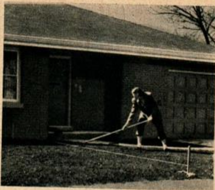
Ci-dessus, mesure de la pente du terrain. Ci-dessous, passage du rouleau sur un sol peu consistant pour éviter les tassements inégaux.
