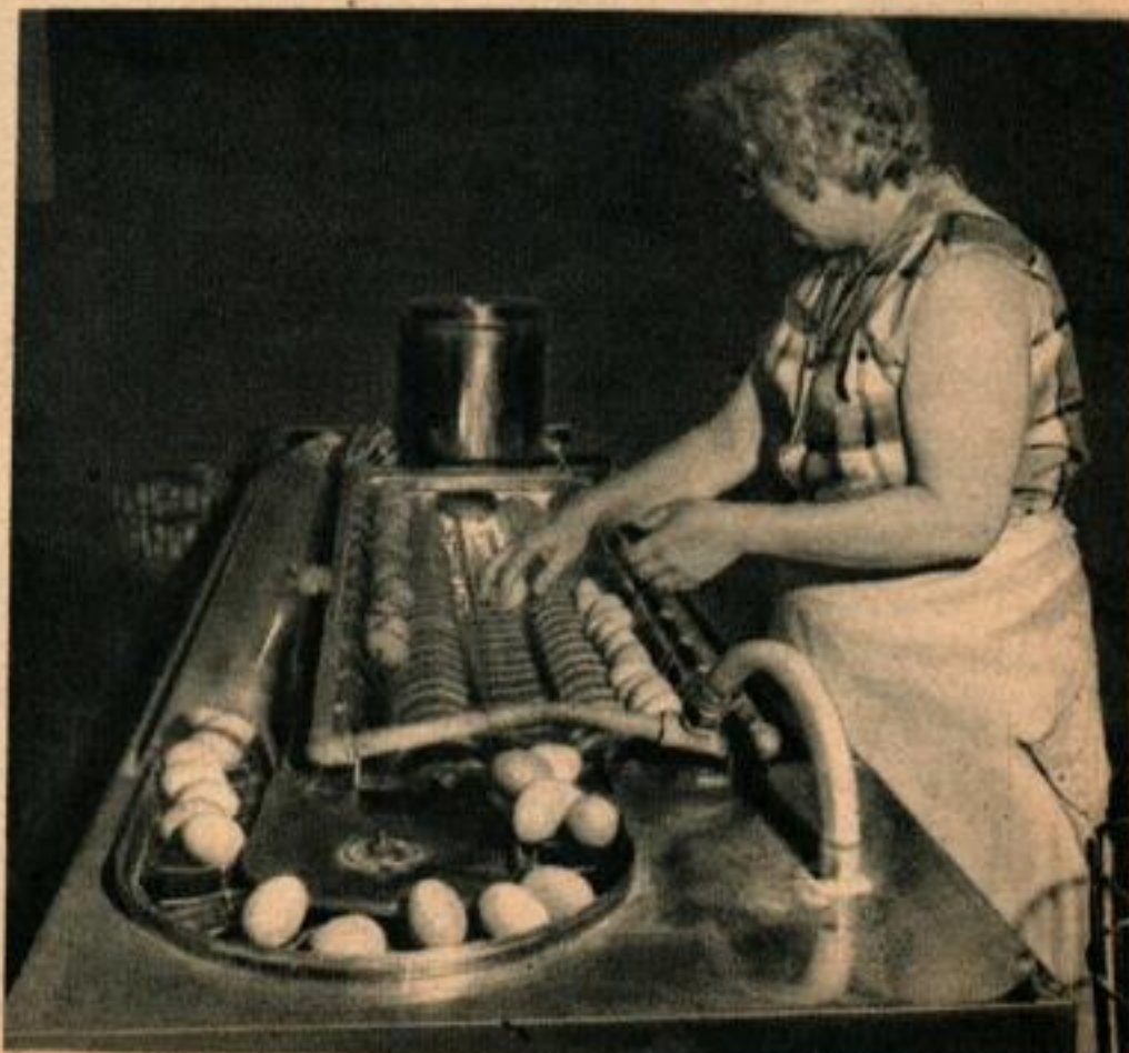
Des douzaines de douzaines d'œufs sont roulées dans la chambre froide. Ci-dessous, les œufs, sur une chaîne sans fin, sont automatiquement lavés et calibrés par une machine spéciale.
