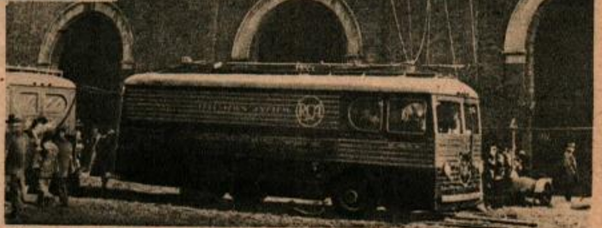
Transmission d'une partie de football par un camion stationné près du stade. C'est avec un équipement analogue que la plupart des grands matches ont été radiodiffusés. Ci-dessus, les opérateurs au travail à l'intérieur du camion.
