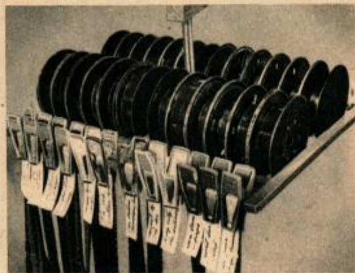
Lorsque les bobines sont placées, les bouts sont pincés en même temps que des étiquettes d'identification par les pinces à linge. Les bobines sont ainsi placées dans leur ordre naturel.
