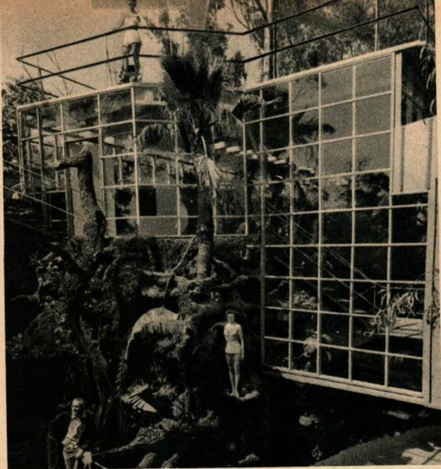
L'entrée principale est le tunnel qui commence à gauche de cette photo. Le mur en verre de droite protège une serre à orchidées.
