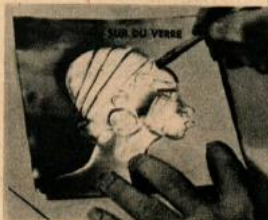
4 SUR LE VERRE APPUYER AVEC UNE GOMME DURE POUR REPOUSSER LE METAL
