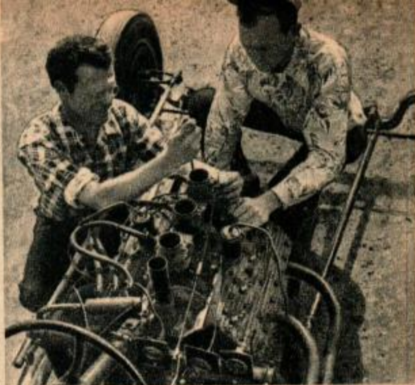
Ce moteur 8 cylindres en V est alimenté par trois carburateurs. Pas de radiateur: si l'eau bout, la vapeur d'eau est rejetée vers le sol par des tuyaux spéciaux.
