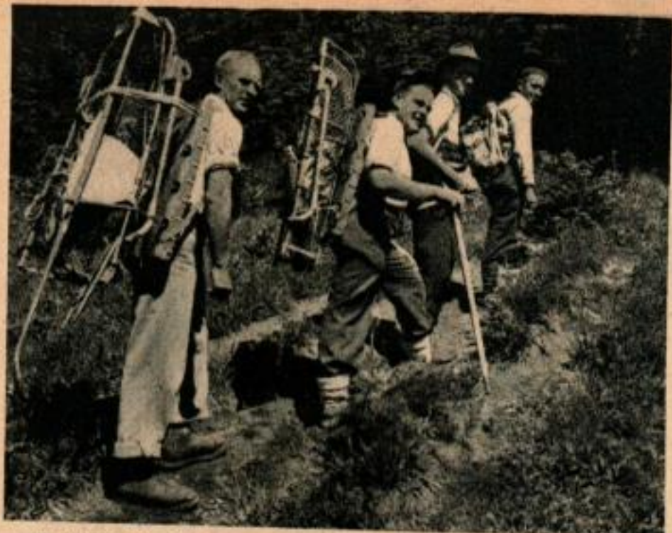
Un brancard récemment mis au point pour les expéditions de secours en montagne, baptisé « le Stokeski », présente les avantages suivants: Démontable, transportable par deux hommes, pouvant être roulé sur le sol sur une roue unique équipée d'un pneumatique (photo ci-dessous), ou pouvant être traîné sur la neige sur un ski. La photo de la page ci-contre montre comment cet appareil est utilisé pour secourir un blessé tombé dans une profonde crevasse.
