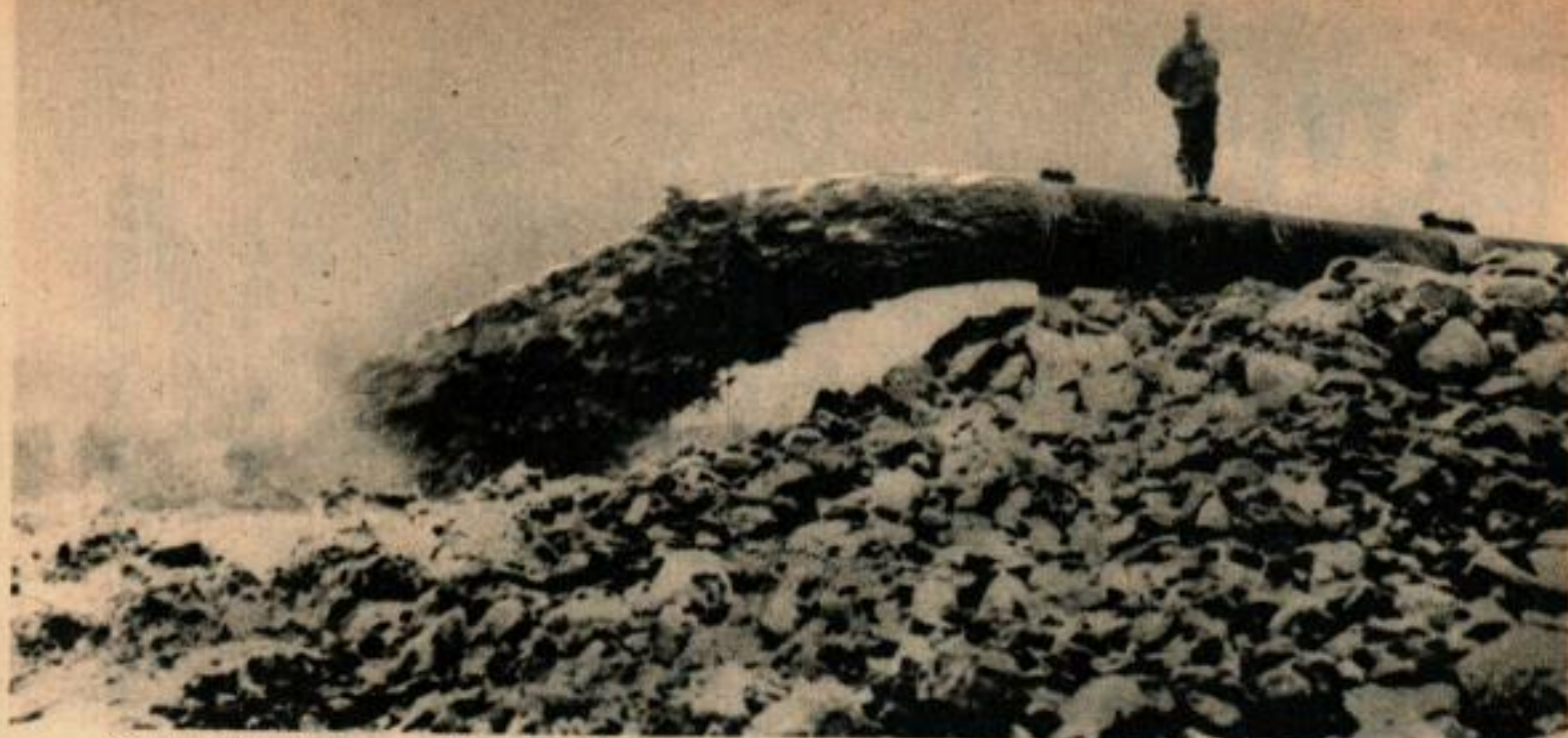
Des quartiers de rocs, de l'argile et de l'eau peuvent être transportés sur près de deux kilomètres dans le tuyau d'évacuation de cette drague. Ce tuyau mesure 90 centimètres de diamètre.
