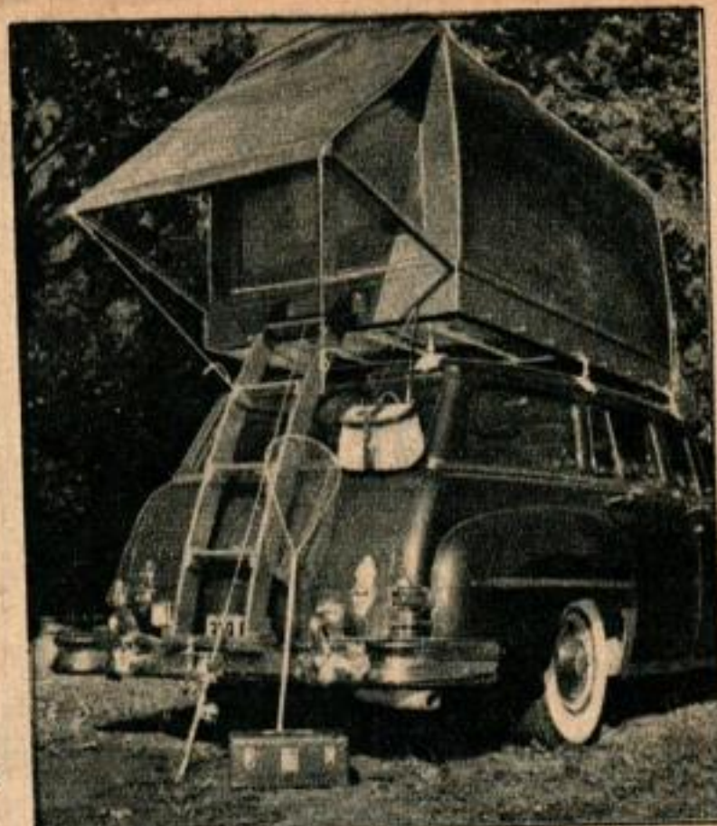
L'échelle conduisant à la couchette est courbée pour suivre le contour de la carrosserie. Elle est articulée au pare-chocs au moyen de charnières.
