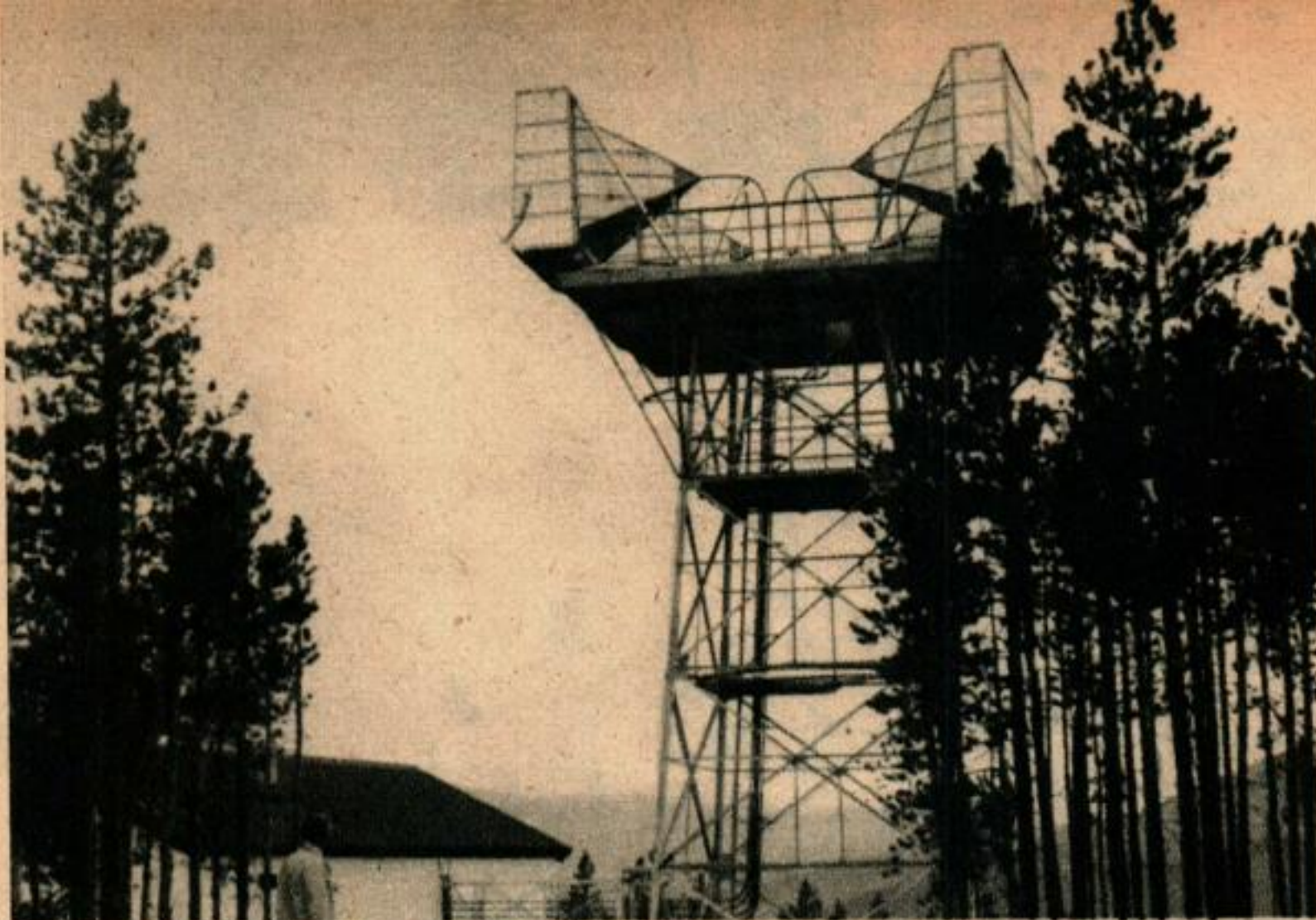
Ces «lentilles» électroniques, au sommet de Buckhorn Mountain, sont reliées par câbles blindés aux appareils qui reçoivent, amplifient et réexpédient les émissions.
