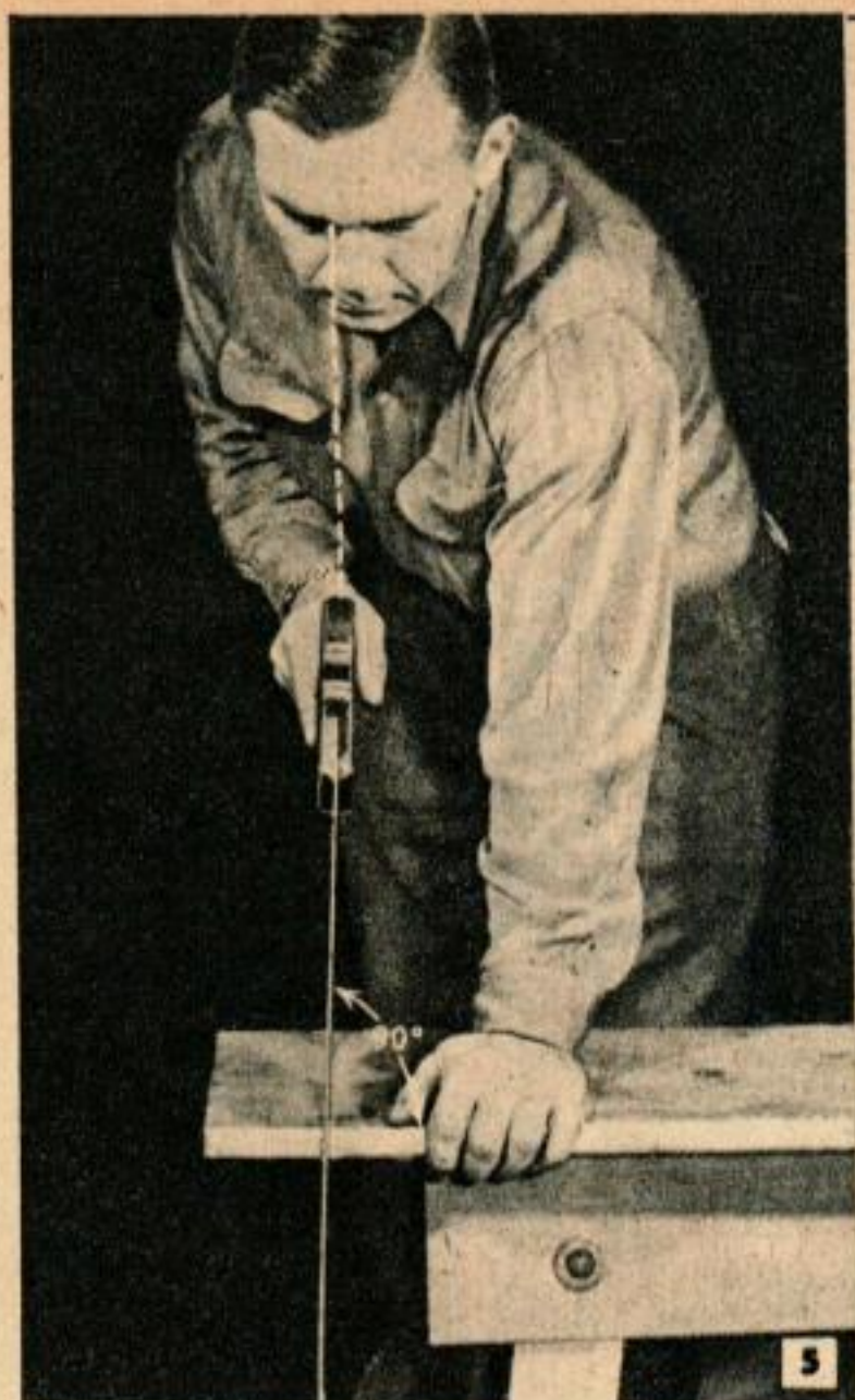
MISE EN PLACE DE LA SCIE AU MOYEN D'UNE ÉQUERRE
