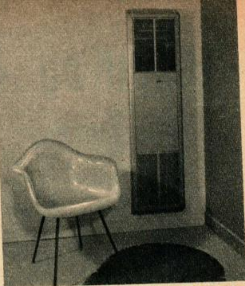
Le chauffe-mur à gaz permet d'apporter un supplément de chaleur en cas de besoin. Cet appareil mural ne tient aucune place sur le sol.
