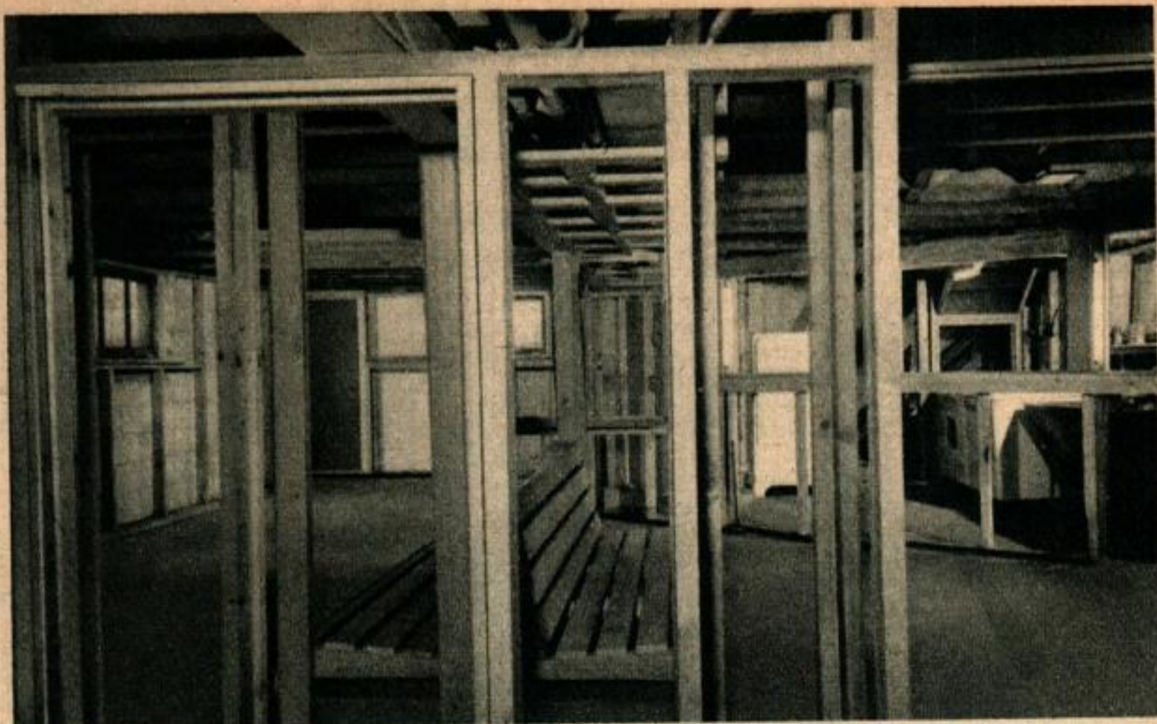
Vue de la charpente avant la pose des revêtements muraux. On voit nettement les deux châssis du mur de séparation servant à constituer des placards entre les deux pièces.
