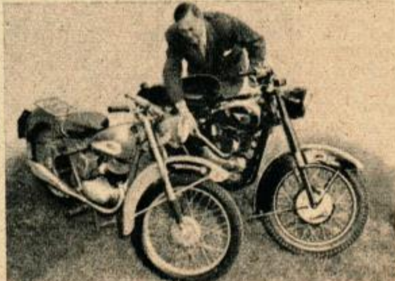
Nouvelle venue dans le domaine des motos américaines voici la «Mustang» monocylindre. Ci-dessous deux B.S.A. anglaises: la «Bantam» (125 cm 3 ) à gauche et la «Golden Flash» (650 cm 3 ) à droite. Cette dernière a un tuyau d'échappement surélevé.
