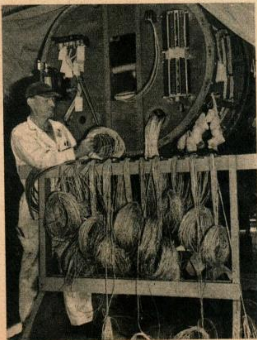
Des kilomètres de fils électriques sont nécessaires aux nombreux appareils électroniques dont est doté l'avion de chasse moderne.
