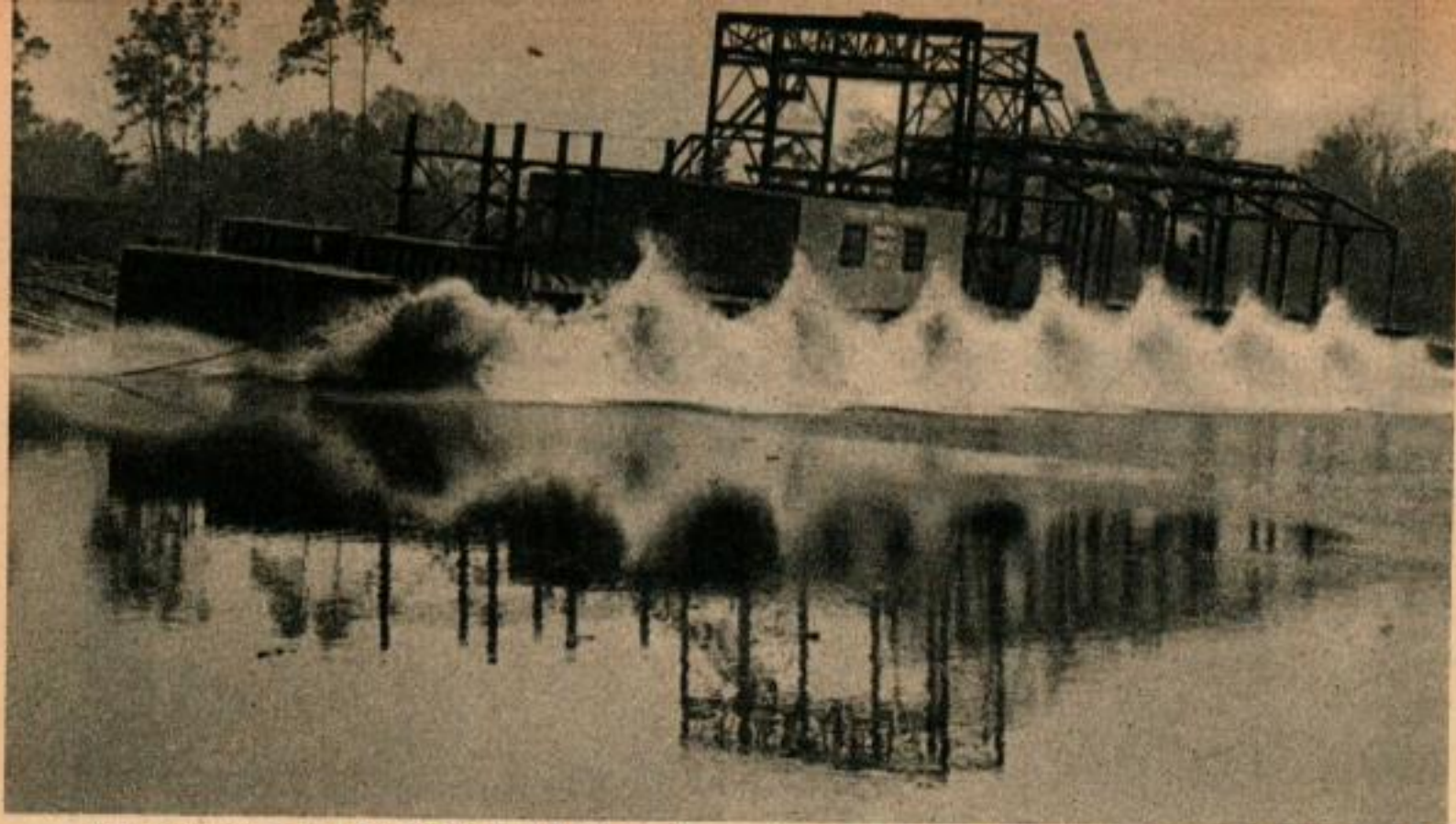
Le gisement de la baie de Sainte-Hélène est recouvert d'une nappe d'eau. L'équipement nécessaire à l'exploitation sera monté sur l'énorme radeau reproduit sur cette photo.
