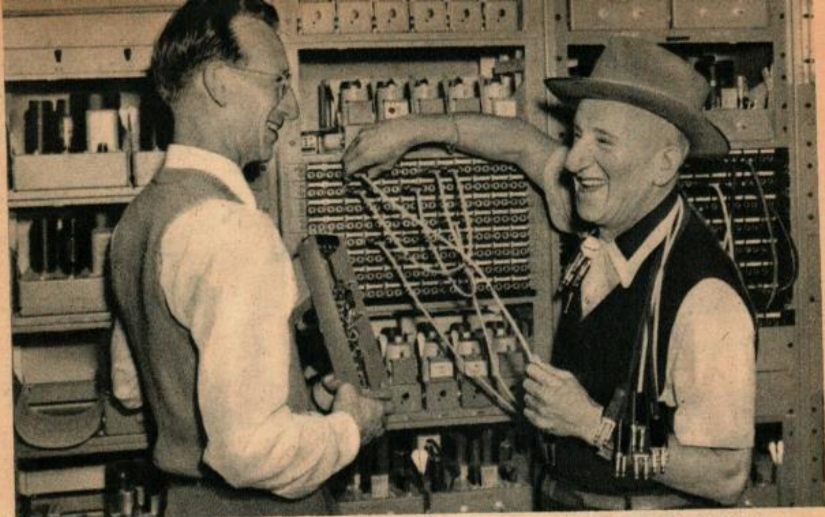
Un artiste «aïde» Winkler à réparer un préamplificateur de microphone devenu bruyant et que l'ingénieur est en train de démonter.
