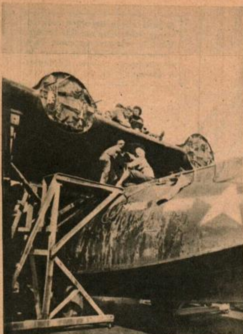
Pièce par pièce, les avions accidentés sont démontés par des spécialistes qui récupèrent le métal et les pièces utilisables. Ci-dessous, on fait l'inventaire des pièces récupérées dans un magasin d'une base aéro-navale.
