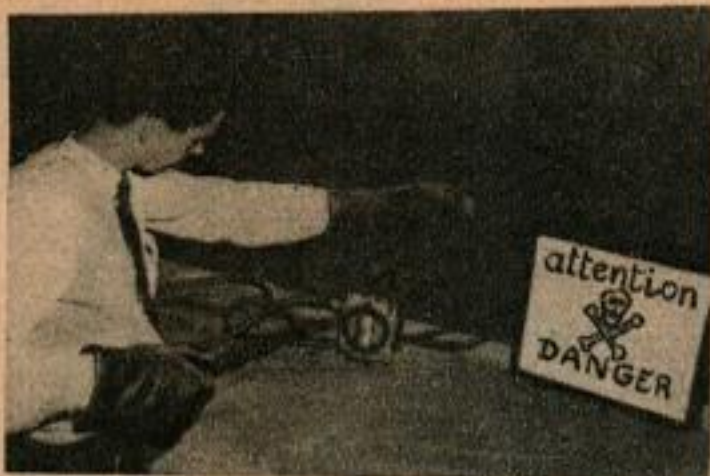
Mesure des radifitions d'une basse (tenue derrière l'instrument) qui a été exposée à un courant de neutrons.
