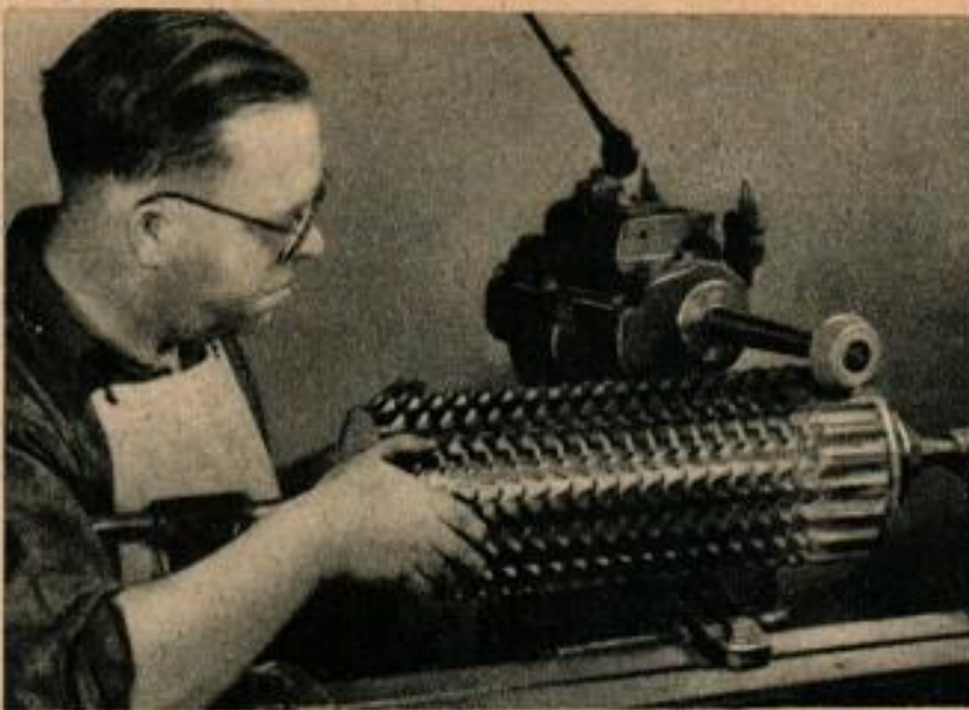
Cet ouvrier qualifié met de longues heures à rectifier à la meule, les dents d'acier de ce couteau à la tolérance d'un millième de millimètre.
