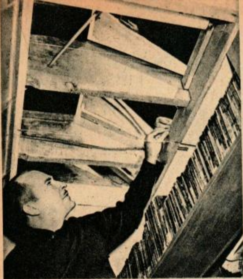
Le châssis vitré est muni de miroirs qui renvoient les rayons solaires dans la maison. Derrière les panneaux se trouvent des tubes pour l'éclairage nocturne.
