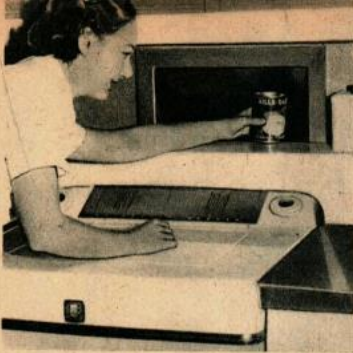
Les détritrus passent par une cloison à charnière dans le mur de la cuisine et tombent dans un coffre à l'extérieur de la maison.
