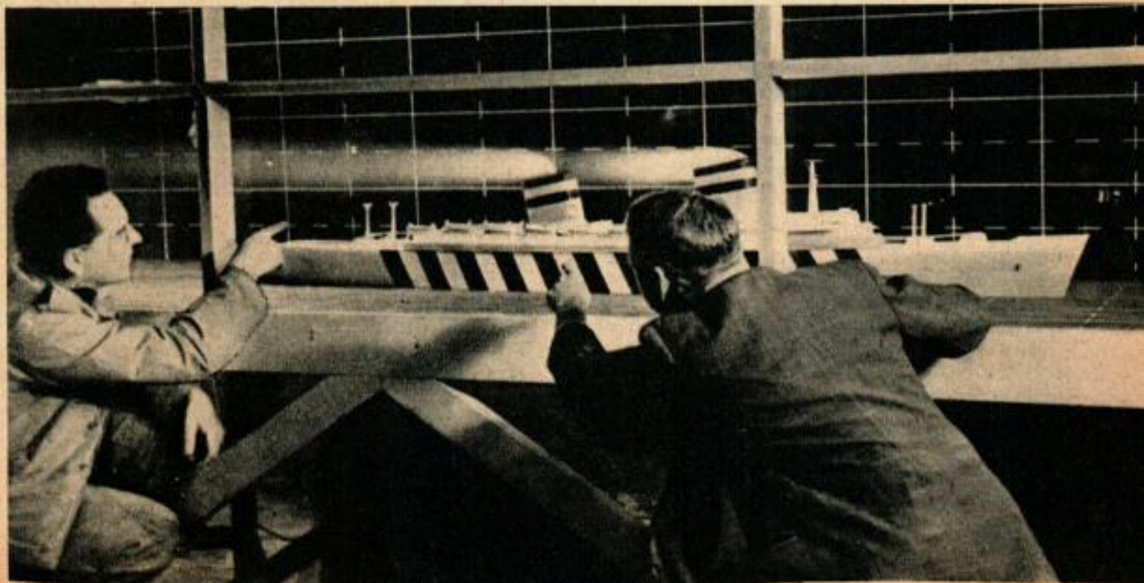
Les ingénieurs vérifient la forme des cheminées dans un tunnel aérodynamique. Ces cheminées ont été abandonnées parce qu'elles avaient donné de mauvais résultats aux essais.
