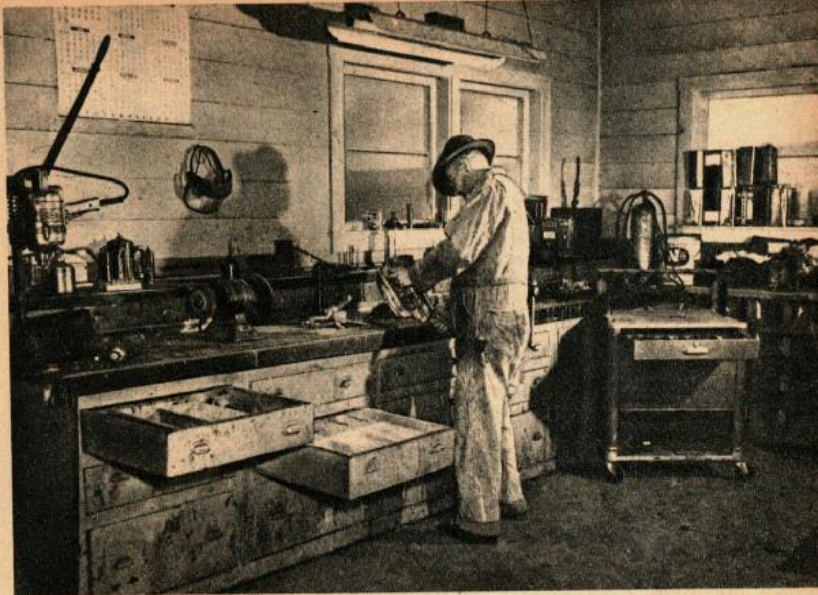
Des tiroirs compartimentés pour les différentes sortes d'outils sont plus pratiques que les râteliers muraux.
