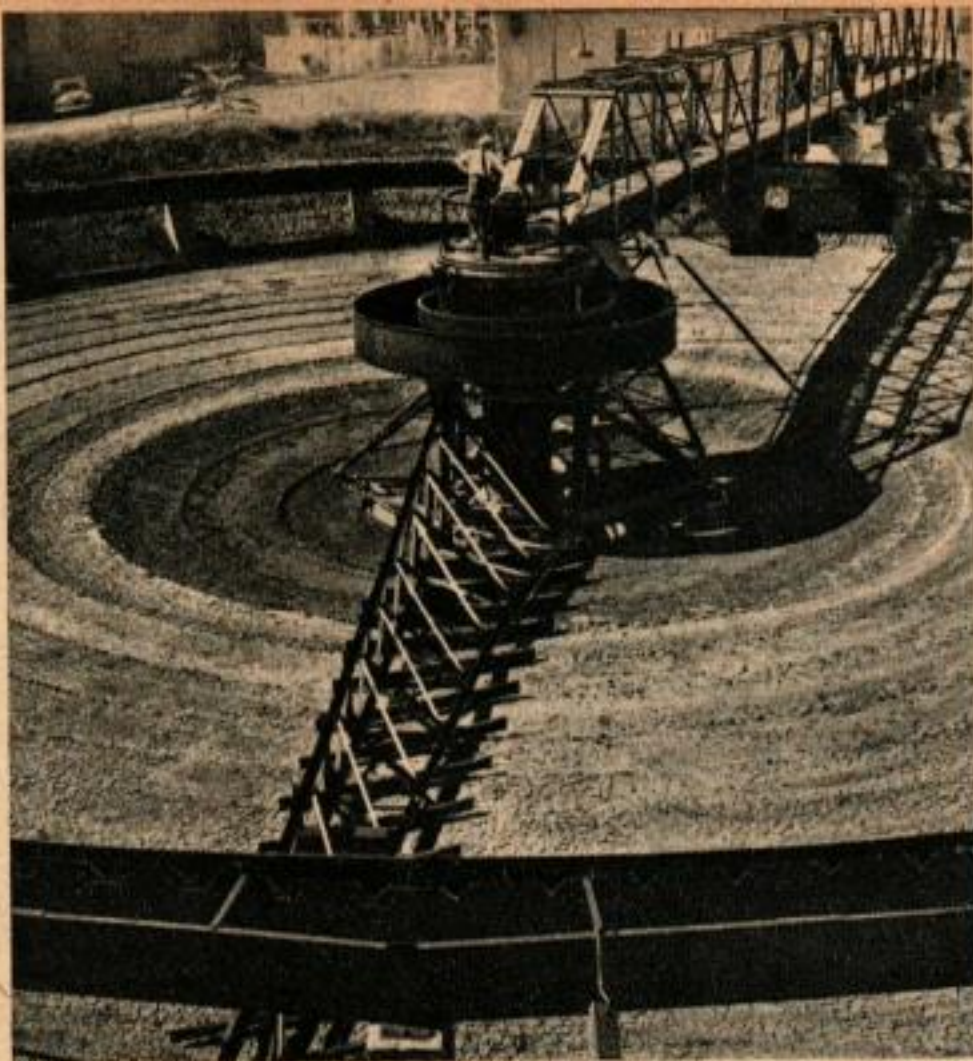
Le bassin étant à sec, on peut voir les bras qui repoussent la boue vers le centre.
