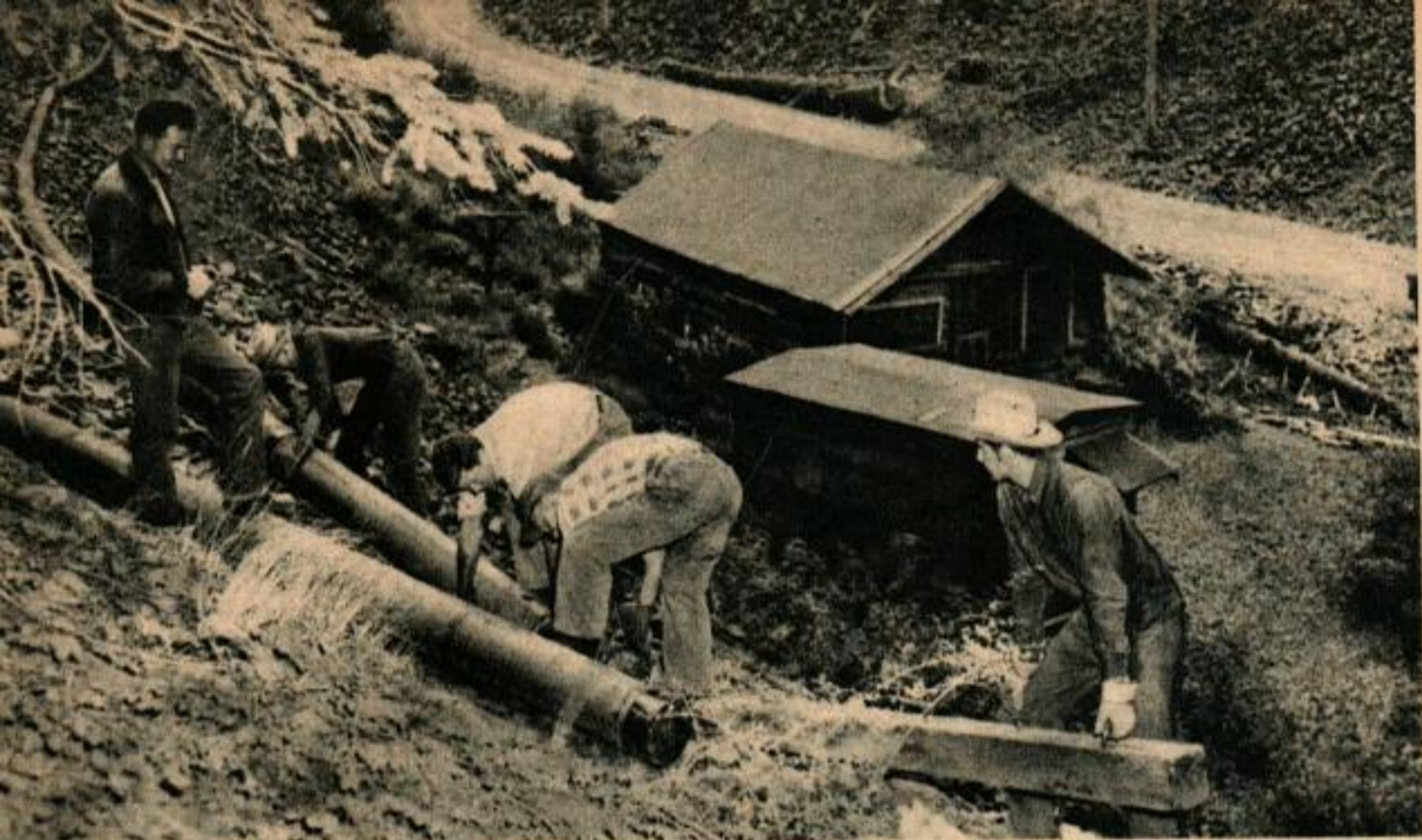
Près d'une vieille cabane de chercheur d'or, on pose un nouveau pipe-line pour la mine de cobalt.
