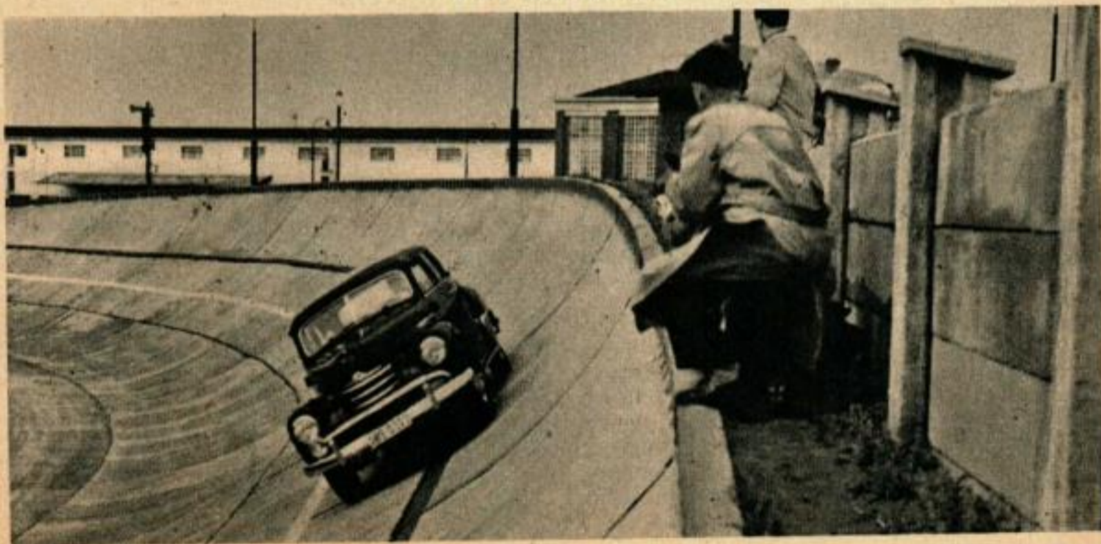
La piste d'essai à l'américaine de l'usine Opel (General Motors) en Allemagne, met les nouvelles voitures à une rude épreuve.
