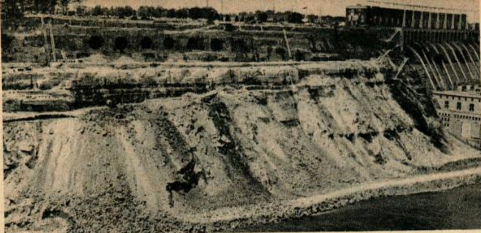
Les sept trous que l'on voit près du sommet de la falaise seront les canaux de prise de la nouvelle centrale. On voit, à droite, la centrale existante.
