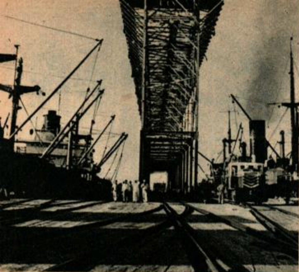
Les installations de manutention sont situées à l'extrémité de la chaussée de Dammam et de la jetée du Golfe Persique.
